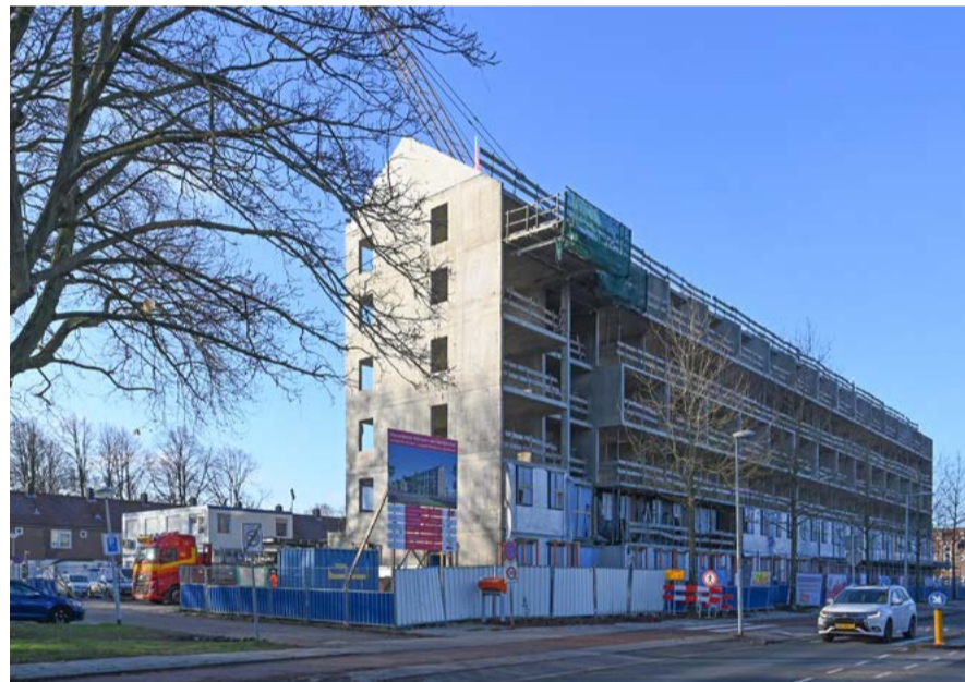
De bouw van het van Swietenhof vordert | Foto Edwin van Eis
